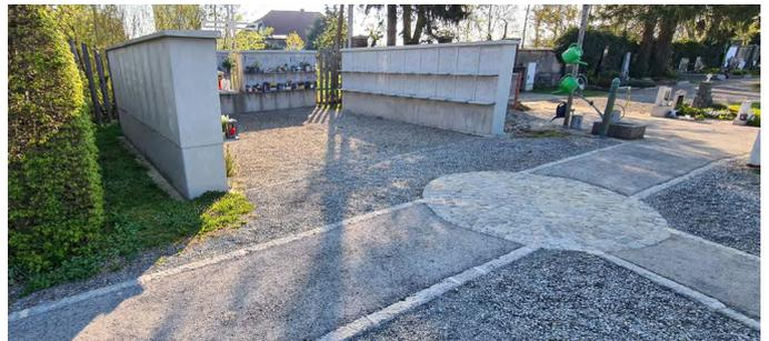
Foto: Wie bisher werden die Hauptwege mit Granitleistensteinen eingefasst und durch ein Asphaltband befestigt. Am Foto ist auch die bereits fertig gestellte neue Urnenwand zu sehen.
