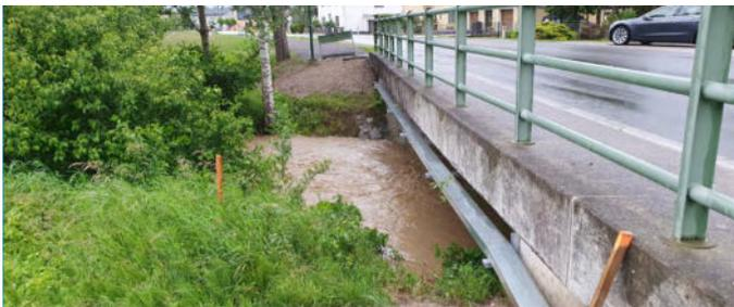
Abbildung: die Kabeltasse an der Zettelbachbrücke
